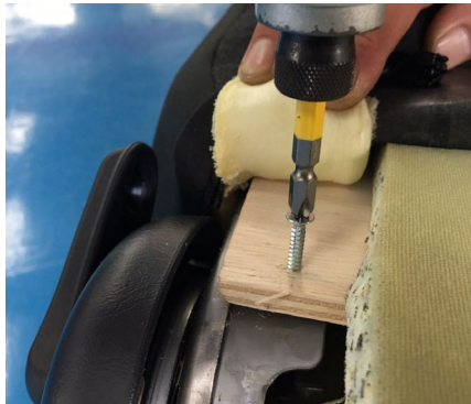
③ 手前左右の小さい穴に付属のビスで、板とフレームを留めて下さい。
